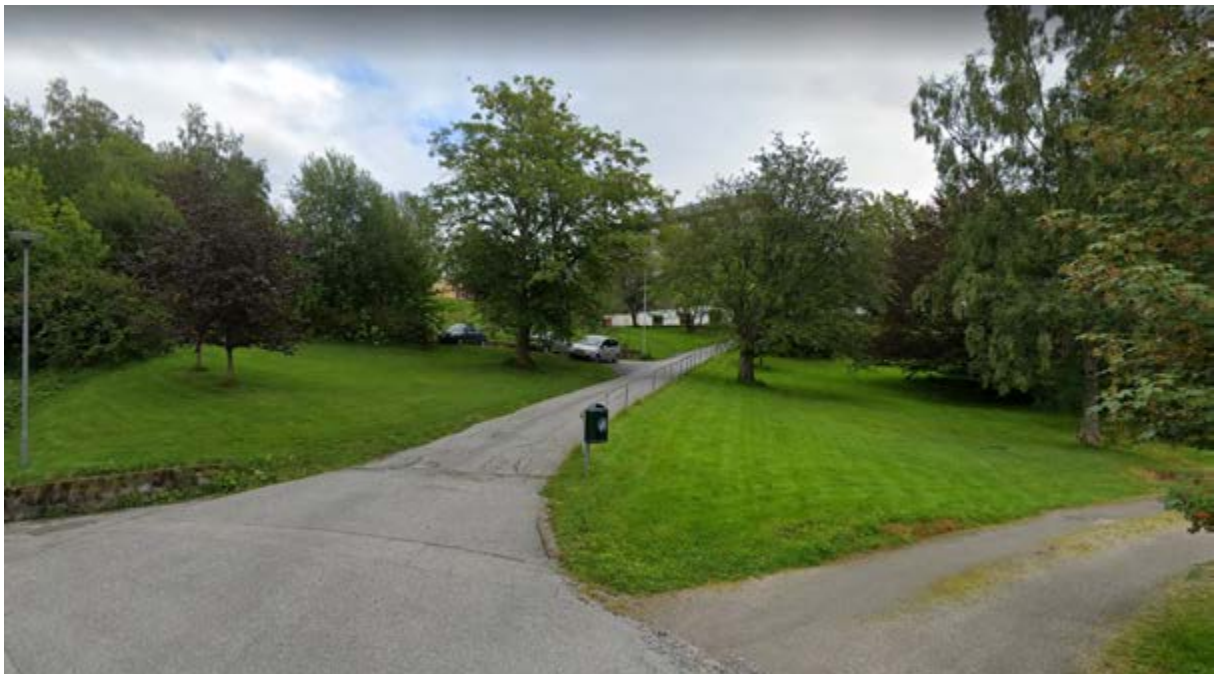
Figur 3.11 Vei opp mot planlagt revet bygg.
