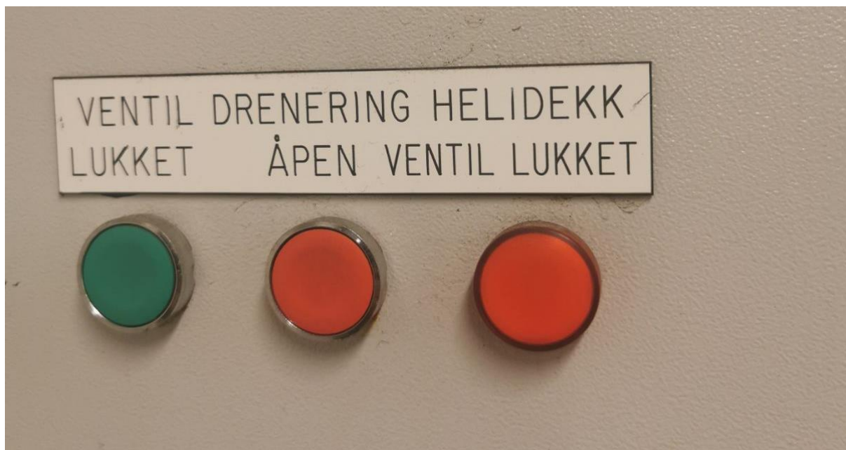
Figur 4. Bilde som viser knappene i pumperommet for å åpne/lukke ventil til avløpssystem.
