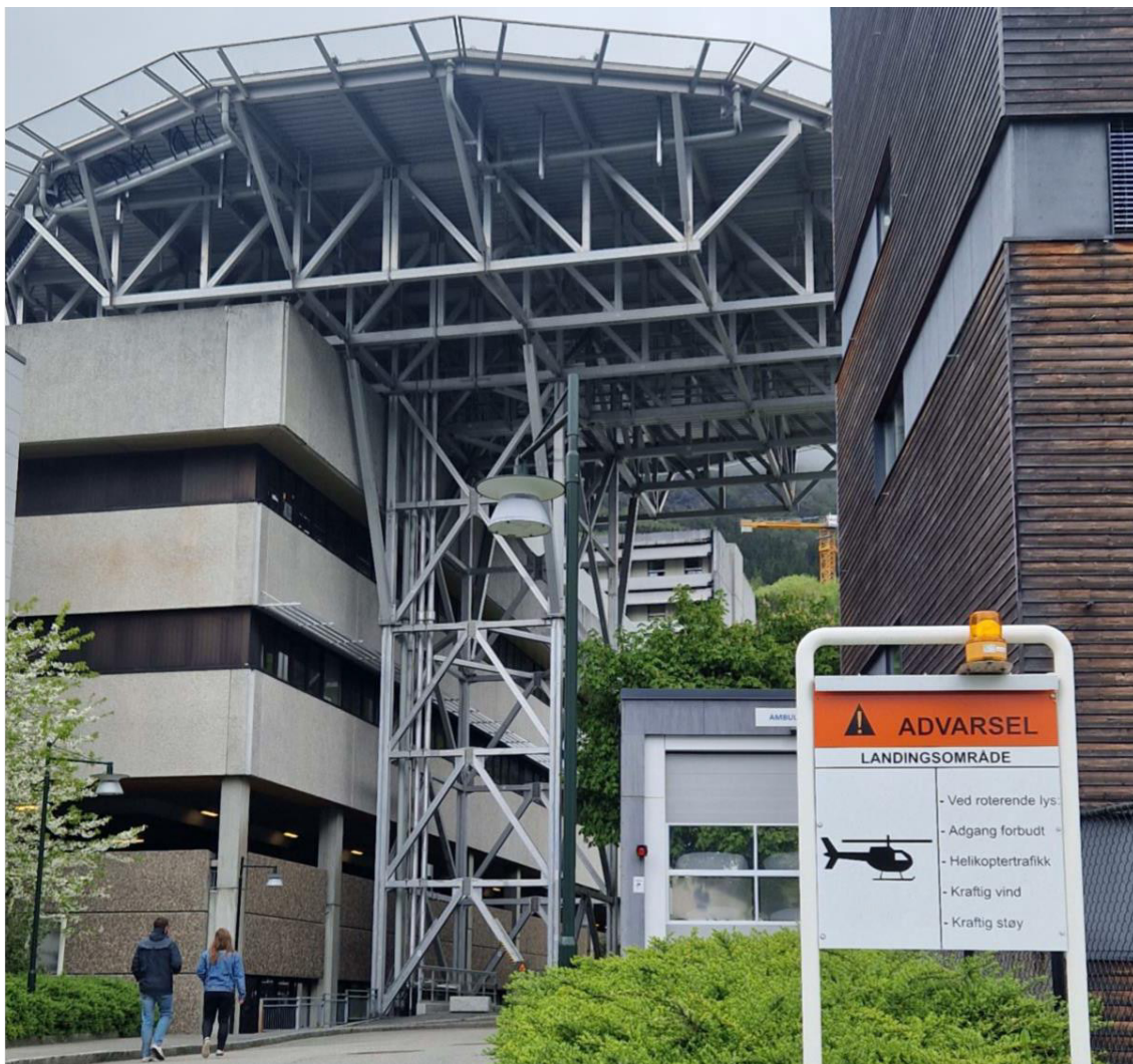
Figur 14. Varselskilt ved helikopterlandingsplassen på Haukeland.
